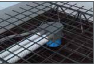
Insert upper reinforcement and pour concrete.
