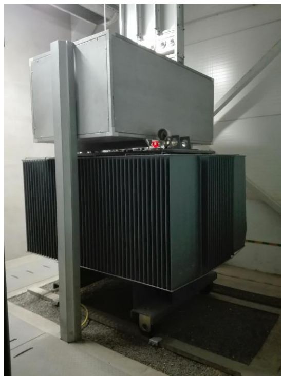
Nuotraukos iš AB „Amilina“ krakmolo cecho - Newton galios transformatorius (2500 KVA)
