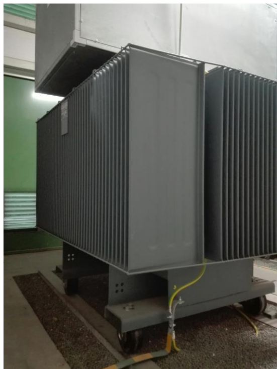
Nuotraukos iš AB „Amilina“ krakmolo cecho - Newton galios transformatorius (2500 KVA)
